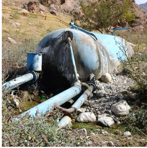
Şəkil 1. Yuxarı bulağın çıxışındakı paylama qurğusu.
