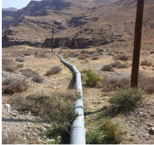
Şəkil 3. Qabaxlıçay hövzəsi bulaq sularının borularla daşınması.
